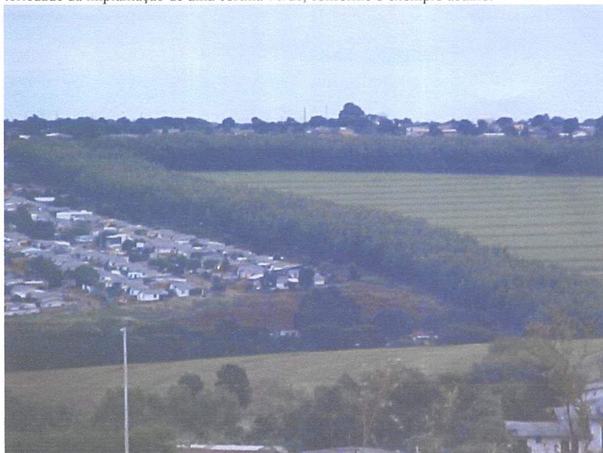
Barreira vegetal na faixa lateral a núcleo residencial. Cascavel. 2005.
